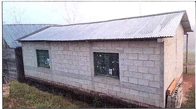
Foto 2: Correctivo para pared y sustitucion de laminas.
