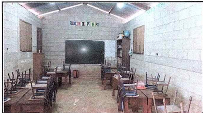
Foto 3: Sustitucion de Piso Ceramico
